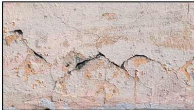
Spalling
